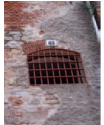
Ventana exterior de una celda con su numeración original.
