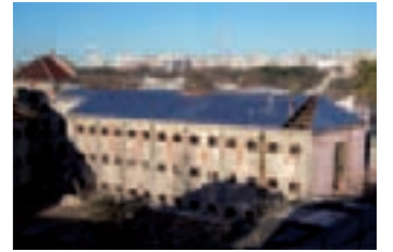
Tres etapas en la recuperación del techo del Ala 1, que alberga al EAC.
